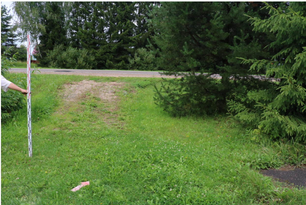
Рис. 11. Археологическое обследование участка по объекту: «Уличные газопроводы дер. Кононово Износковского района Калужской области». 2023 г. Точка фотофиксации 2. Вид с ЮВ.
